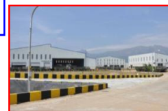
HANGAR III & IV
