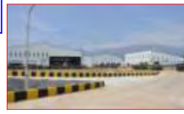
HANGAR III & IV
