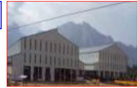
HANGAR I & II
